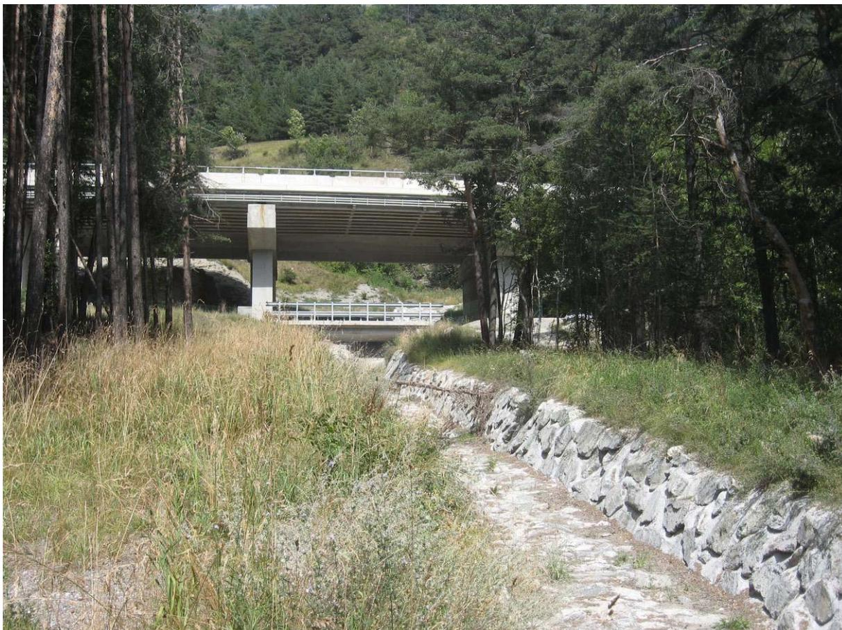
Rio Perilleux – alveo rivestito in massi cementati, con leggeri fenomeni di erosione delle scogliere, ponte in cemento armato e viadotto autostradale A32
