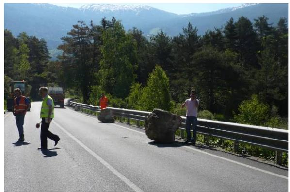
Considerata l'estensione e il dislivello, la presenza di blocchi disarticolati in corrispondenza della nicchia di distacco e di numerosissimi blocchi di dimensioni anche plurimetriche variamente appoggiati e incastrati nel versante, il versante è da considerarsi tuttora soggetto a al rotolamento sporadico di massi di ogni dimensione
