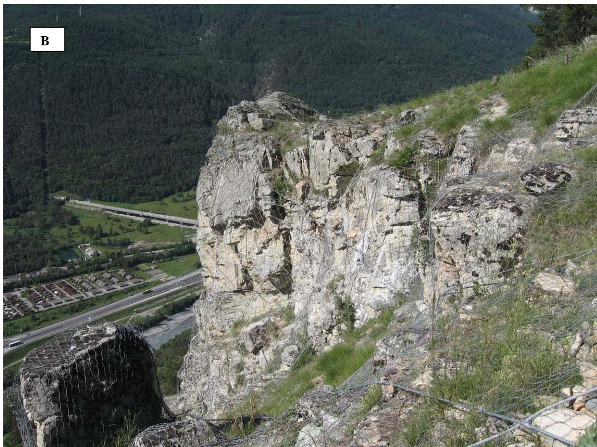
Lungo la Strada Statale SS n. 24 del Monginevro, fra la frazione Casermette e Pont Ventoux, al confine con il Comune di Salbertrand, sono stati realizzati dall'ANAS estesi interventi sul versante, consistenti in barriere paramassi disposte in più ordini e reti ad aderenza.
