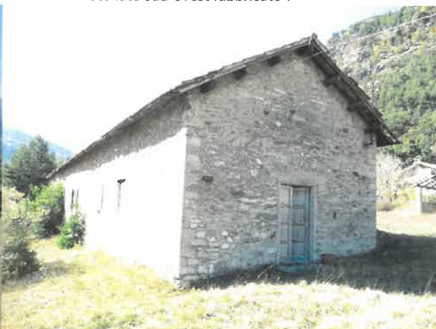
Foto lato sud-ovest fabbricato 7
