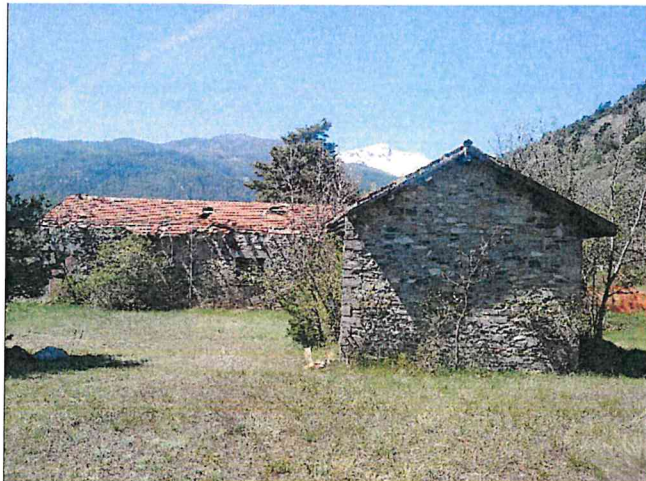
Foto lato est fabbricato 5-6
