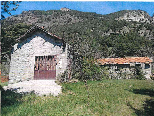
Foto lato sud fabbricato 5-6
